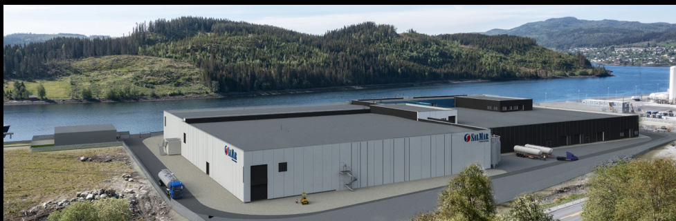
SalMar Tjuin, settefiskanlegg, under oppføring
