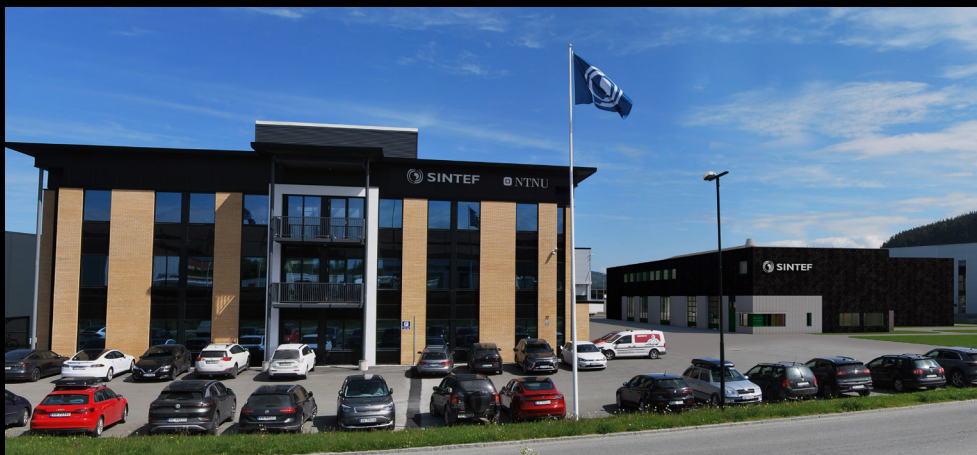
SINTEF Torgård, ombygging til lab og verksted, Trondheim, under oppføring
