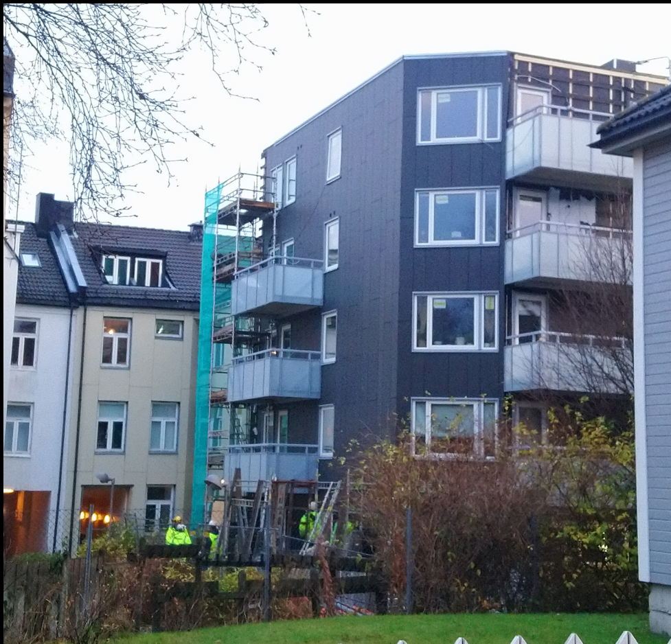
TOBB Frostaveien - fasaderehabilitering, Trondheim, ferdigstilt i 2021
