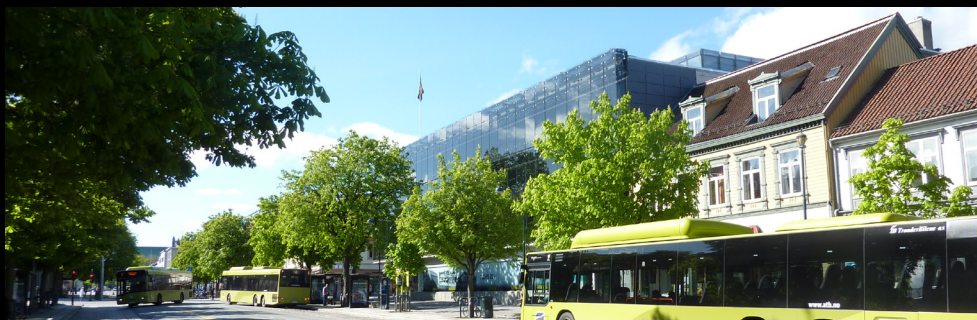
Lykkegården i Munkegata, Trondheim, ferdigstilt i 2015
